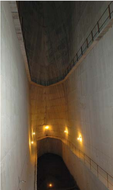
LA PRESA DESDE ADENTRO. CADA ELEMENTO TIENE UNA PARED DE 3 M. DE ANCHO.
