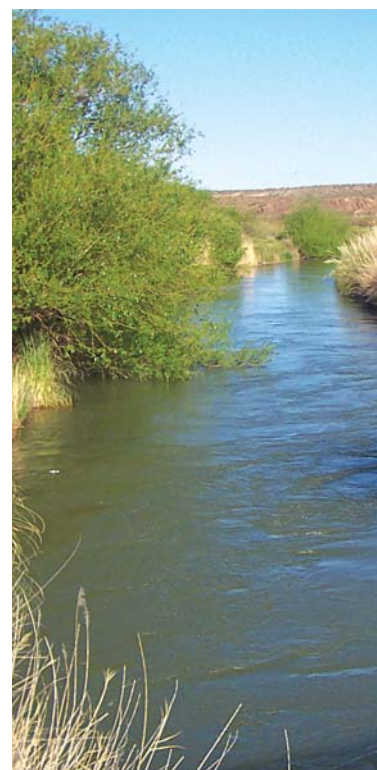
OBRA DE RIEGO: CANAL PRINCIPAL NORTE
