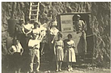
LOCOMOTORA INSTALADA EN LA OBRA
