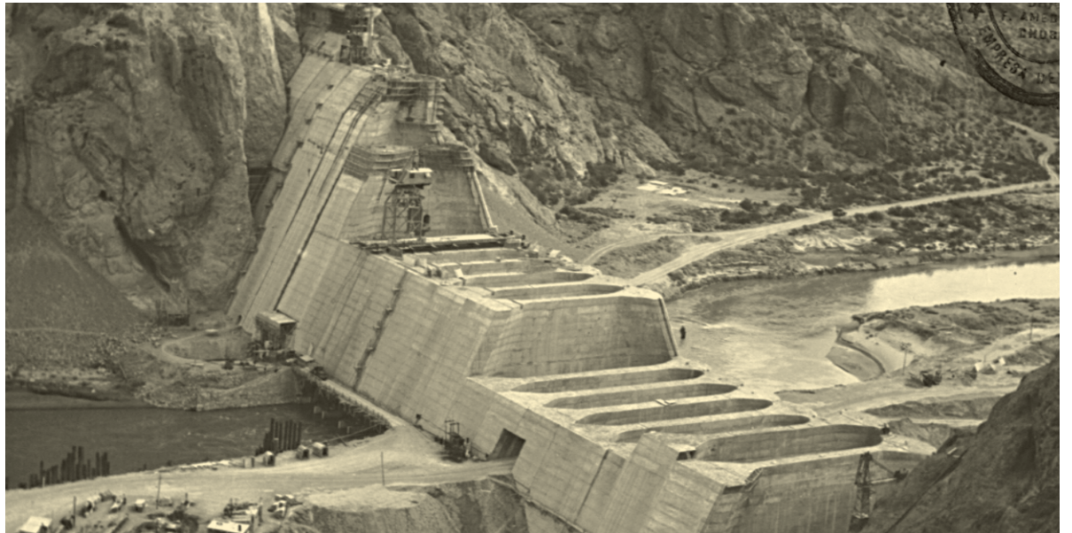
SE PUEDE APRECIAR LA CONSTRUCCIÓN DEL DIQUE FLORENTINO AMEGHINO
