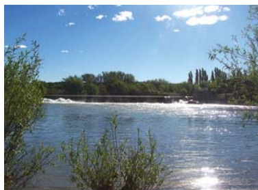
OBRA DE RIEGO: BOCA TOMA
