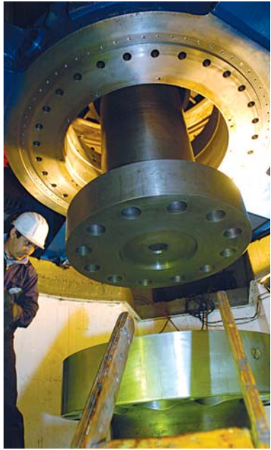
PERSONAL DE HASA COLOCANDO EL ROTOR
