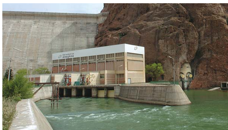
SE PUEDE APRECIAR LA CASA DE MÁQUINAS Y EN LA ROCA LAS VÁLVULAS DE RIEGO.
