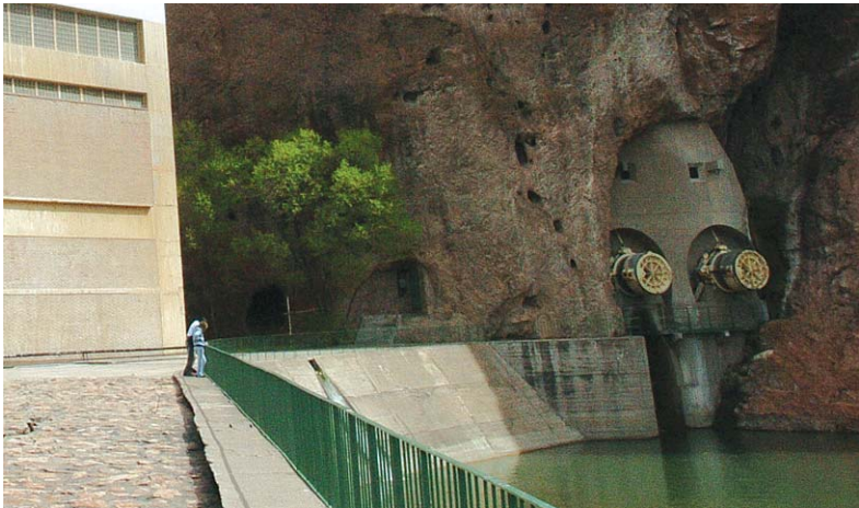
VÁLVULAS DE RIEGO. SOBRE EL MARGEN DERECHO DE LA FOTOGRAFÍA PODEMOS APRECIAR DOS VÁLVULAS DE RIEGO, UNA DE LAS ALTERNATIVAS PARA EROGAR AGUA.
