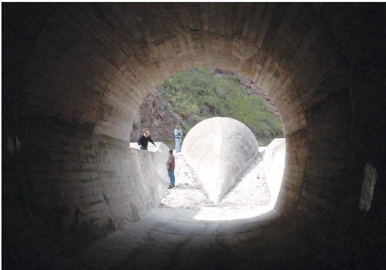
SALIDA DELVERTEDERO. ESTA “VÍA DE ESCAPE” PARA EL AGUA NUNCA HA SIDO UTILIZADA.
